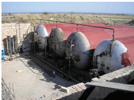
Рис. 10. Биогазовая установка КФХ «Ак-Сарай», 200 м 3 Объем реакторов, м 3 – 200, пропускная способность по навозу, – 12 т/сутки, – 4000 т/год, производительность по биогазу, – 360 м 3 /сутки, – 120000 м 3 /год, газгольдер, м 3 – 20
