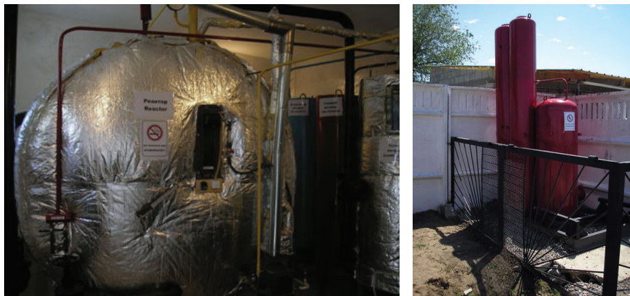
Рис. 7. Биогазовая установка Профессиональный лицей №43, 10 м 3 Объем реакторов, м 3 – 10, пропускная способность по навозу, – 0,6 т/сутки, т/год 200 т/год, производительность по биогазу – 18 м 3 /сутки, – 6000 м 3 /год, газгольдер, м 3 – 10
