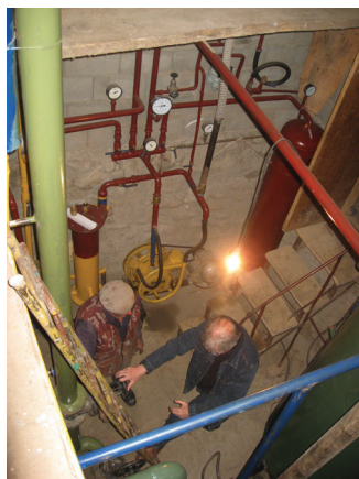
Рис. 8. Биогазовая установка КХ «Фаворит», 25 м 3 Объем реакторов, м 3 – 25, пропускная способность по навозу, т/сутки – 1,5, пропускная способность по навозу, т/год – 500, производительность по биогазу, м 3 /сутки – 45, производительность по биогазу, м 3 /год – 15000, газгольдер, м 3 – 5
