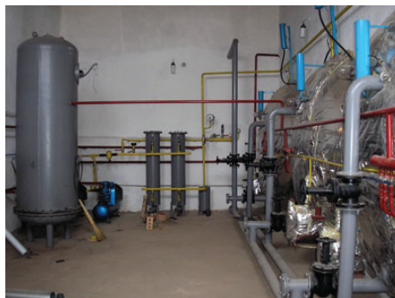
Рис. 10. Биогазовая установка КФХ «Ак-Сарай», 200 м 3 Объем реакторов, м 3 – 200, пропускная способность по навозу, – 12 т/сутки, – 4000 т/год, производительность по биогазу, – 360 м 3 /сутки, – 120000 м 3 /год, газгольдер, м 3 – 20
