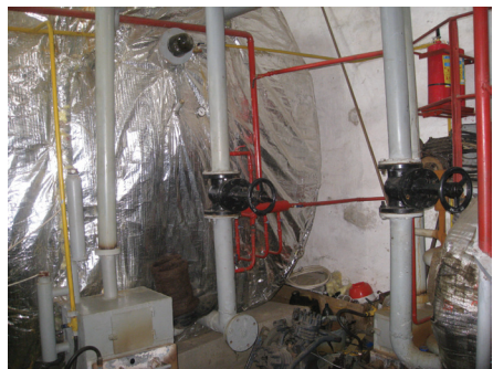
Рис. 9. Биогазовая установка Жамаат «Заря», 50 м 3 Объем реакторов, м 3 – 50, пропускная способность по навозу – 3 т/сутки, – 1000 т/год, производительность по биогазу – 90 м 3 /сутки, – 30000 м 3 /год, газгольдер, м 3 – 10
