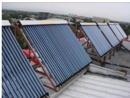
Рис. 27. Вакуумный солнечный водонагревательный коллектор площадью 16 м 2 (8 коллекторов) с общей емкостью баков-накопителей 1200 л (4 бака) для ГВС гостиницы.
