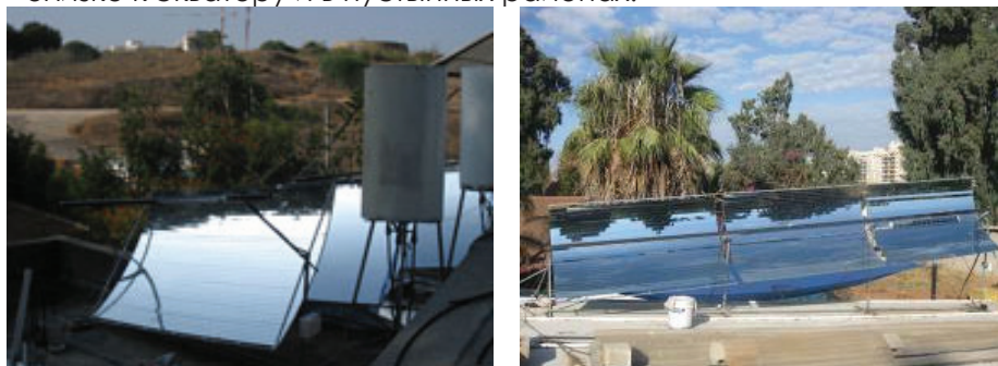
Рис. 16. Солнечный коллектор с параболическим концентратором
