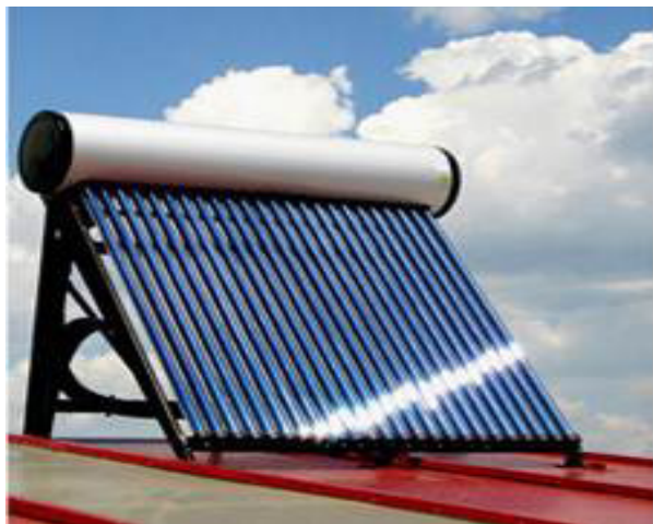
Рис. 7. Вакуумная солнечная водонагревательная установка.
