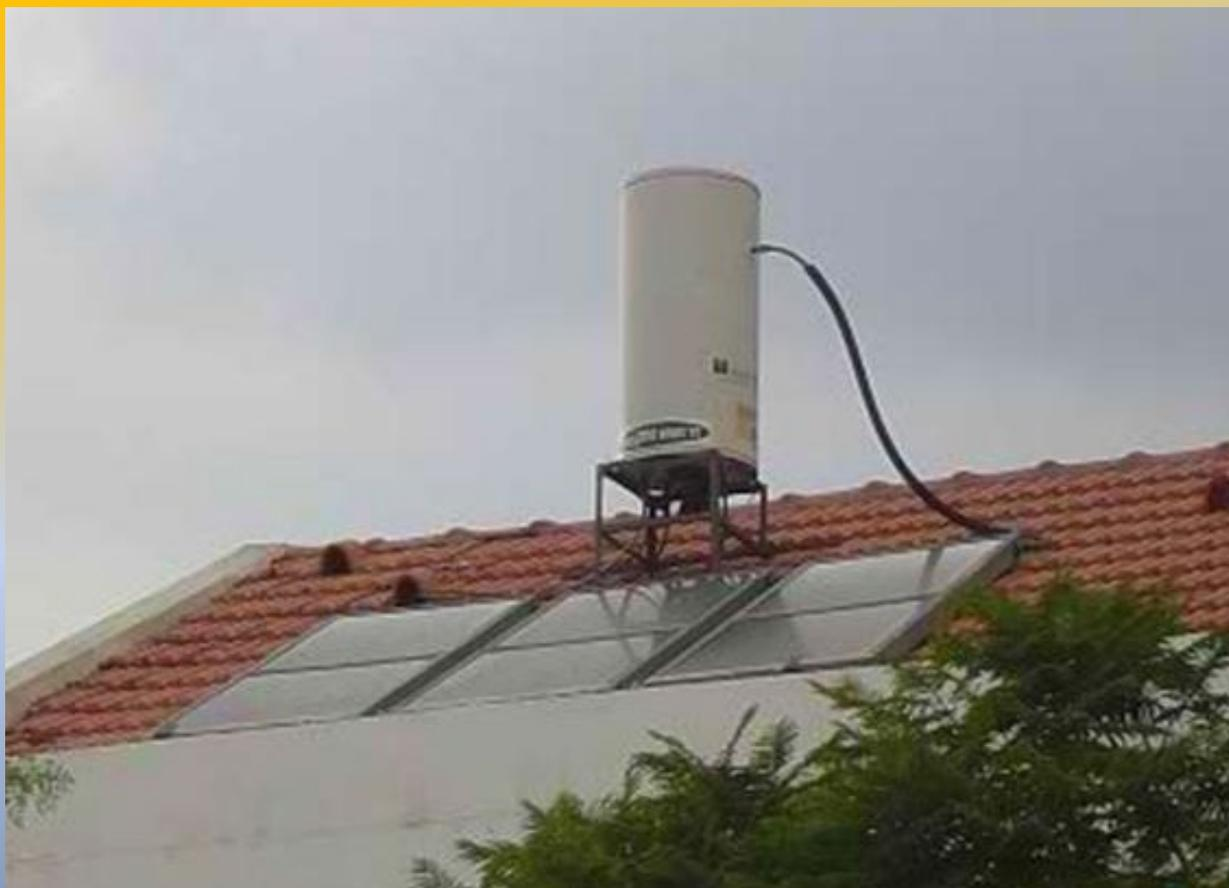
Плоский солнечный коллектор для горячего водоснабжения
