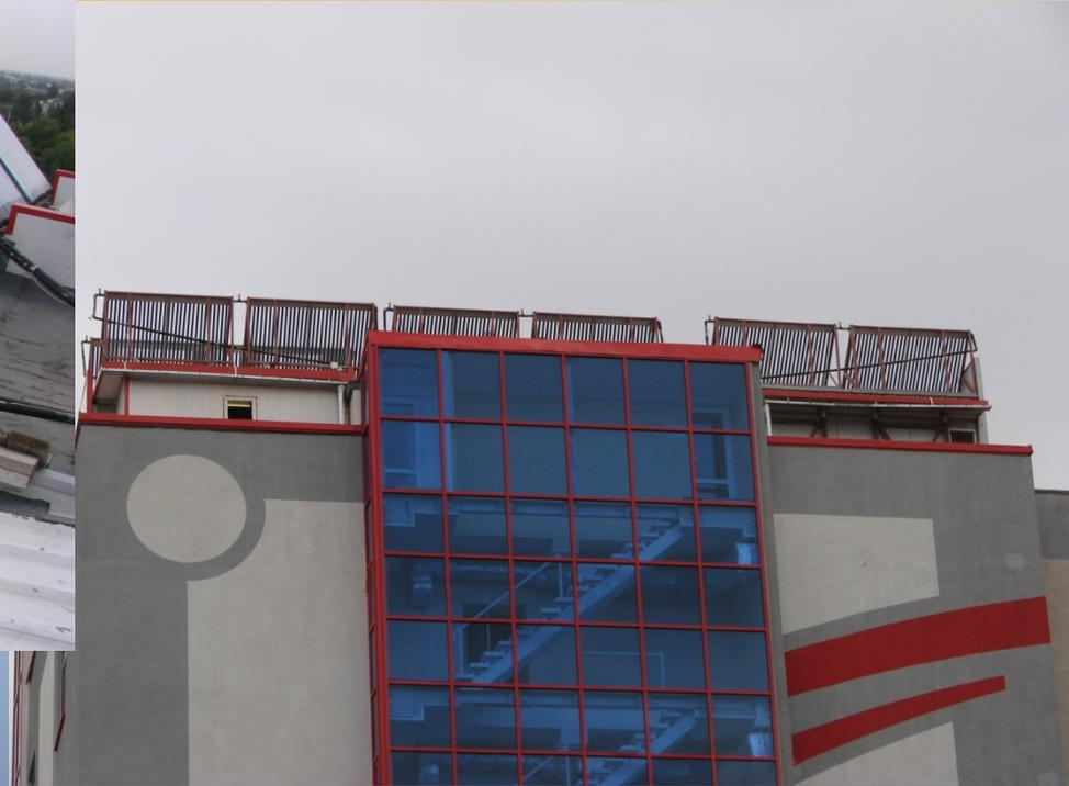
**Система вакуумных коллекторов** площадью 16 м<sup>2</sup> (8 коллекторов) с общей емкостью баков-накопителей 1200 л (4 бака) для ГВС.
